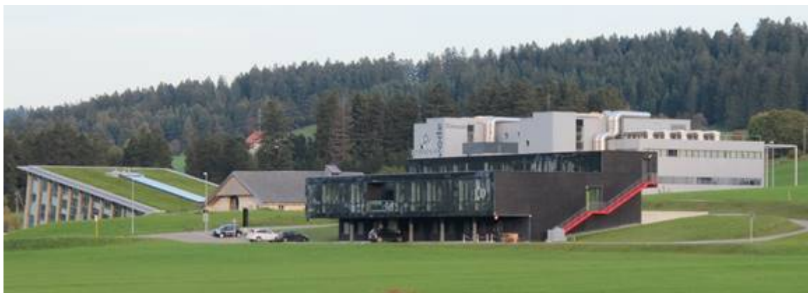
Zone industrielle Le Crêt-du-Loche, La Chaux-de-Fonds,
